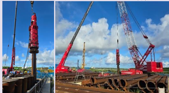
沖縄地方 フライング油圧ハンマー打設
