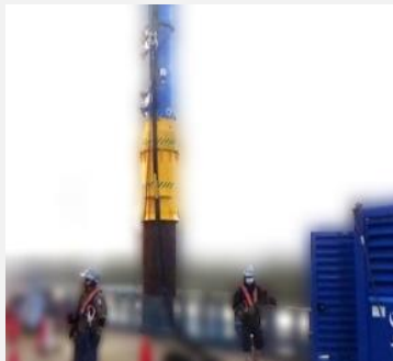
近畿地方 フライング油圧ハンマー打設
