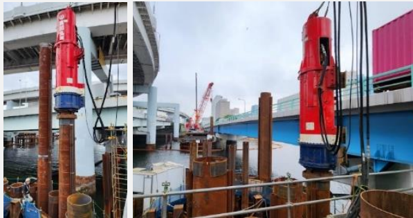
北陸地方 フライング油圧ハンマー打設
