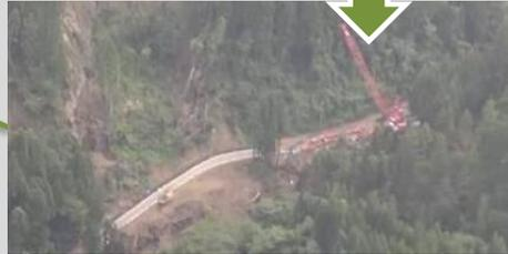
現在、国道249号の復旧工事では、鋼管栈橋SqCピア工法が採用され、仮栈橋の架設工事が順調に進んでいます。この工法の採用により、施工効率の向上や工期短縮、安全性の確保が図られ、早期復旧にも繋がっています。
