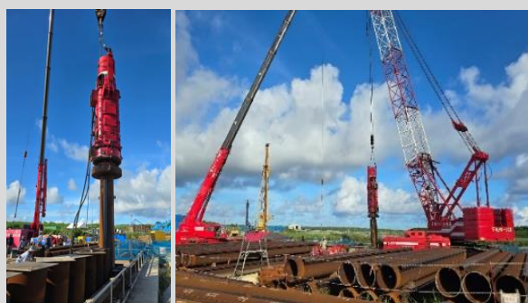
沖縄地方 フライング油圧ハンマー打設
