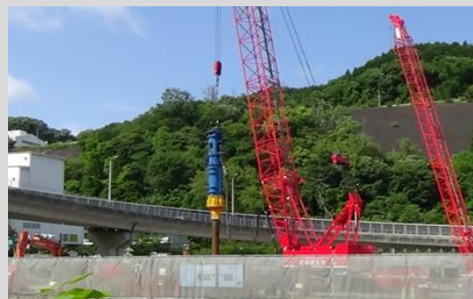
関東地方 フライング油圧ハンマー打設
