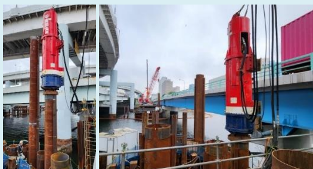
関東地方 フライング油圧ハンマー打設
