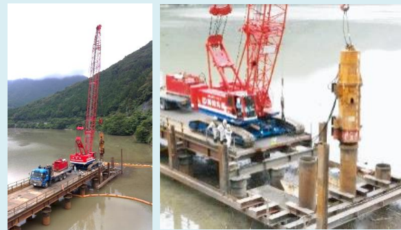
近畿地方 フライング油圧ハンマー打設
