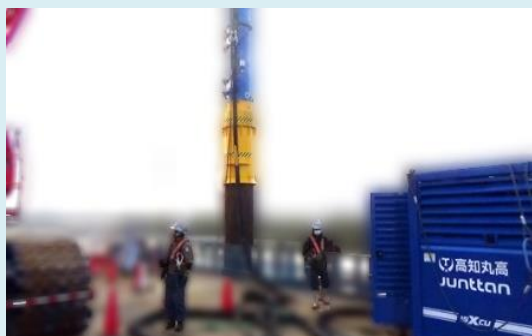
近畿地方 フライング油圧ハンマー打設
