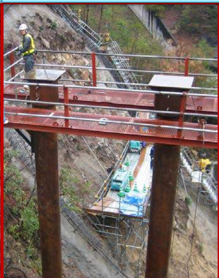
③杭頭キャップ設置
