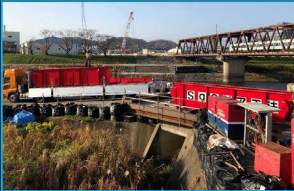
①地組ヤード部材搬入、荷降し
