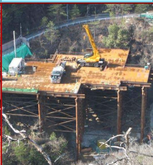
⑨架設完了
