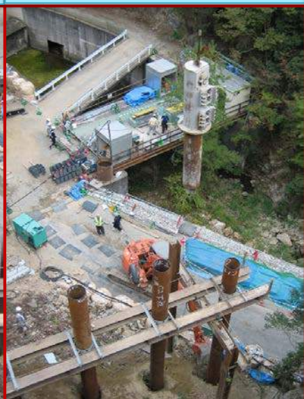
②支持杭建込
