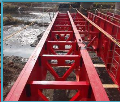
⑧横組材順次設置
