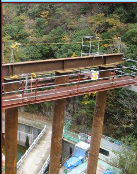
④受桁架設
