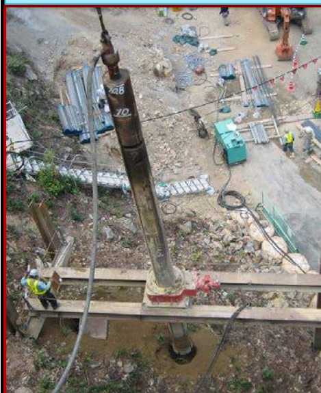
①杭位置削孔
