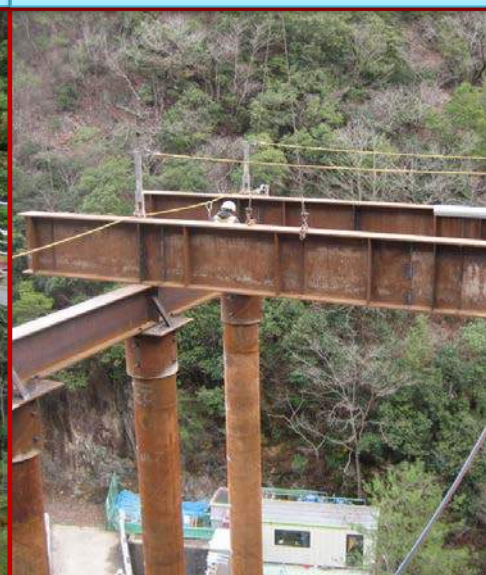
⑤主桁架設
