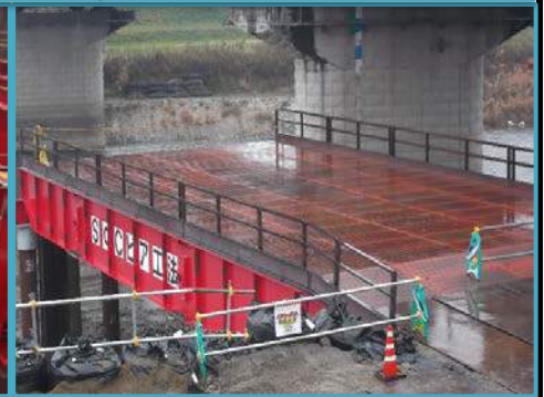
⑨覆工板・防護柵設置
