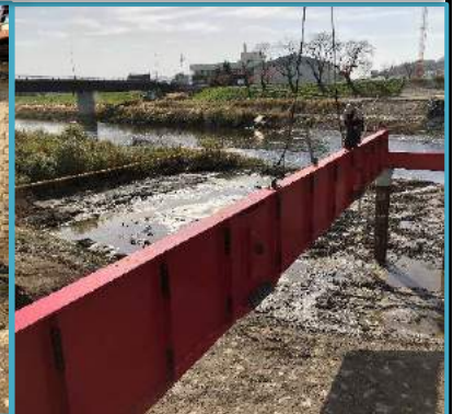
⑥主桁順次架設
