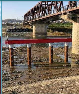
⑥支持杭・受桁設置
