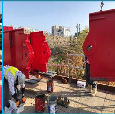
②地組ヤード部材設置
