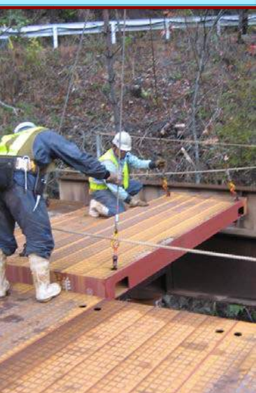
⑧覆工板・橋面工設置
