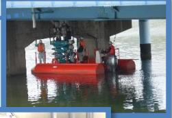
橋梁点検自航艇
