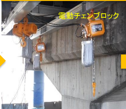
吊り金具電動チェンブロック取付
