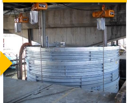
水替、水中ポンプ2int
