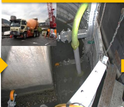
底面遮水コンクリート打設
