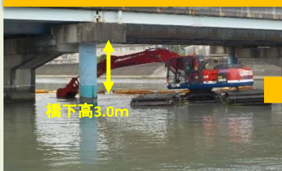
橋下高3.0m内での掘削作業
