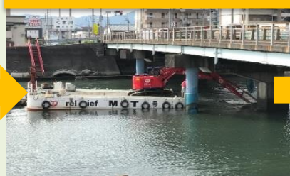
水位より5.5mの掘削
