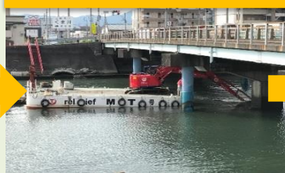
水位より5.5mの掘削
