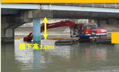
橋下高3.0m内での掘削作業
