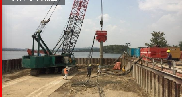
ナイル架橋建設工事
