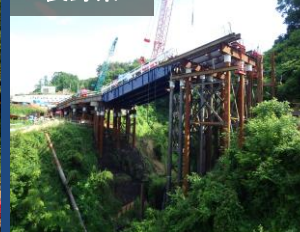
中部横断自動車道 月明川橋下部工事
