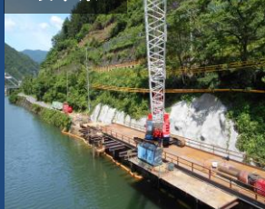
市道林～丸山線災害復旧工事
