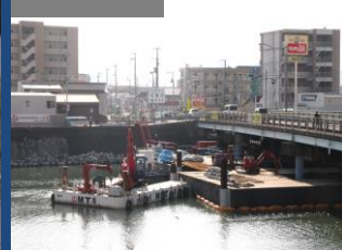
久万川大橋橋梁耐震工事
