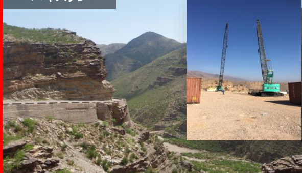
N70号線改修工事
