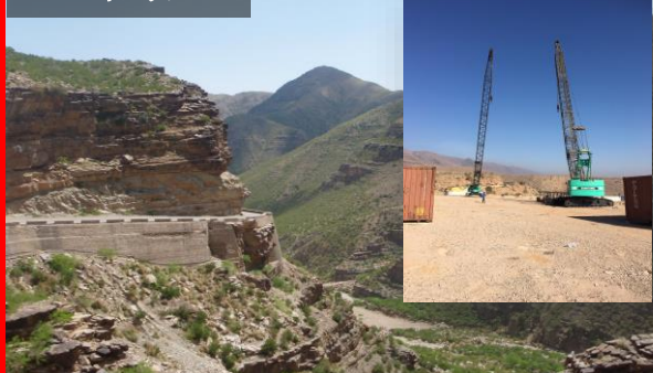
N70号線改修工事
