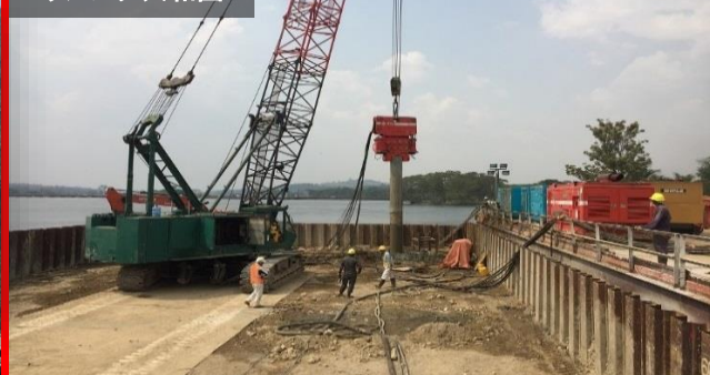
ナイル架橋建設工事
