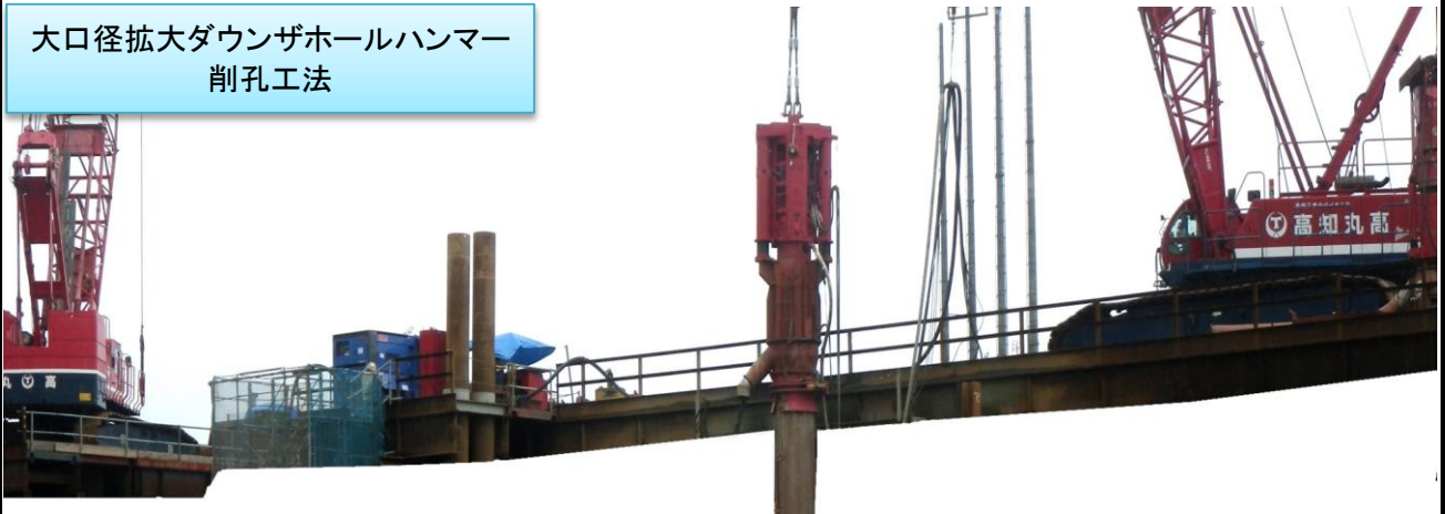
1. 鋼管矢板打設杭芯セット
