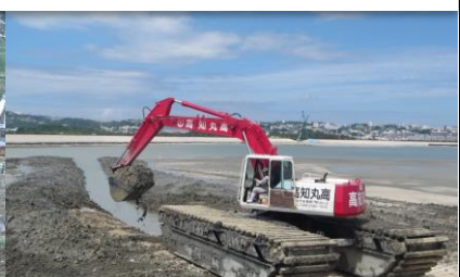
沖縄県 浚渫工事
