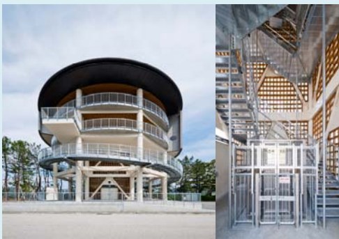
第一号津波避難タワー併設 手巻式ゴンドラ
